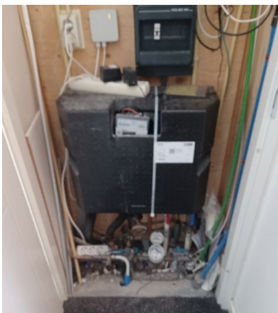
Stekkerdoos open onder de warmte-afleverset
